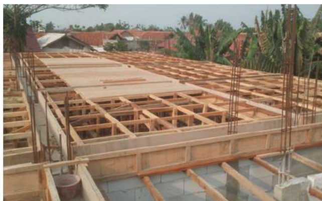
Pemasangan Kerangka Cor Lantai 1
