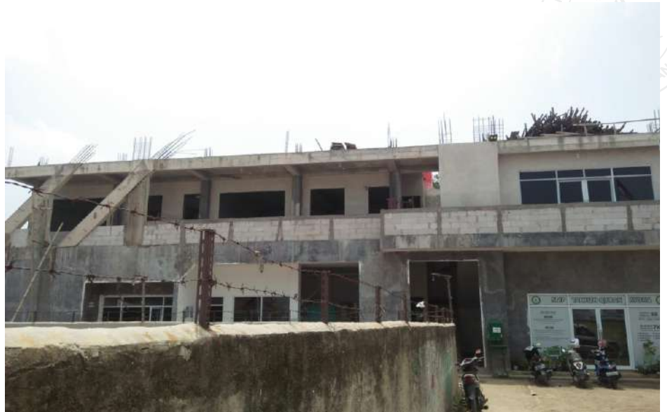
Kondisi Gedung SMP Tahfizh Qur'an Rydha (30 September 2021)
