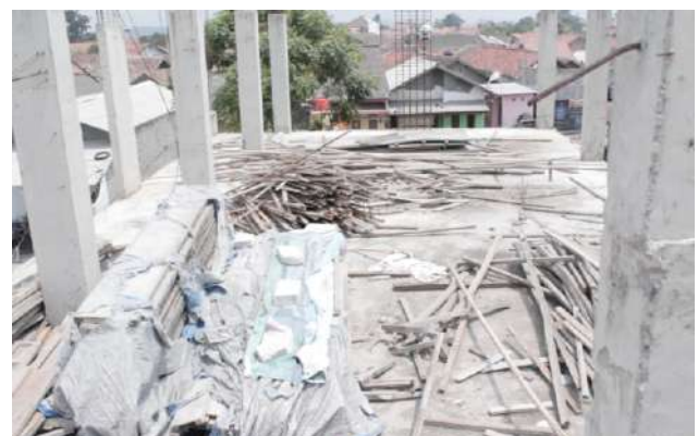
Setelah Pengecoran Lantai 1
