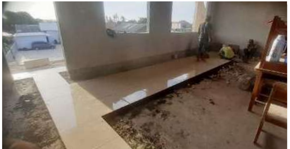
Pemasangan Keramik lantai 2
