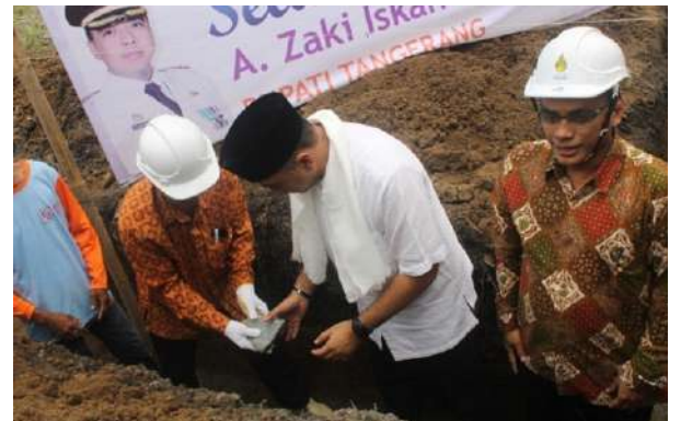
Proseki peletakan batu pertama pembangunan SMPTQ Rydha oleh Bupati Tangerang
