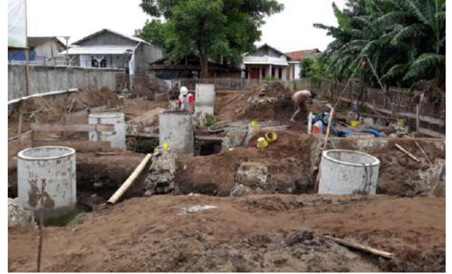
Pengecoran dan Pemasangan Pondasi
