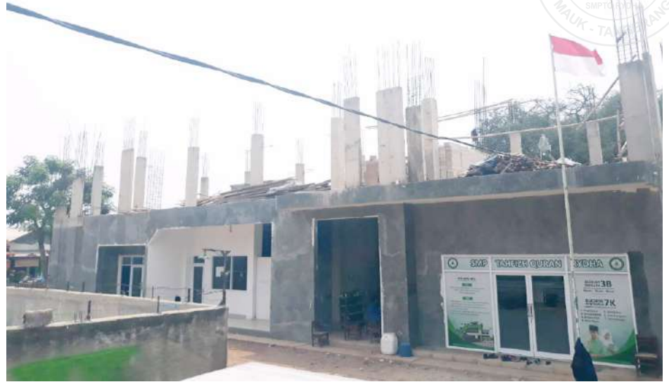
Kondisi Gedung SMP Tahfiz Qur'an Rydha (November 2019)
