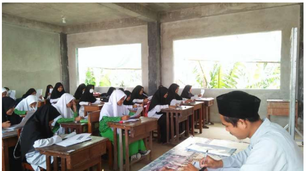
Kondisi lantai dua yang belum terpasangnya jendela
